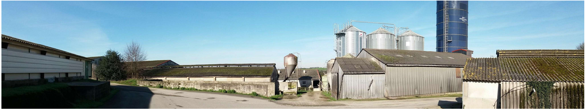
Vue 6 avant travaux
